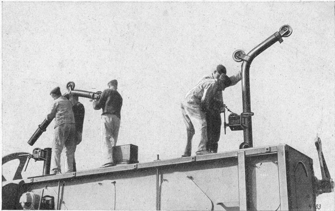
Bild 12. Die Ausleger für die Schwenkkrane (IV/7) einstecken und befestigen.
