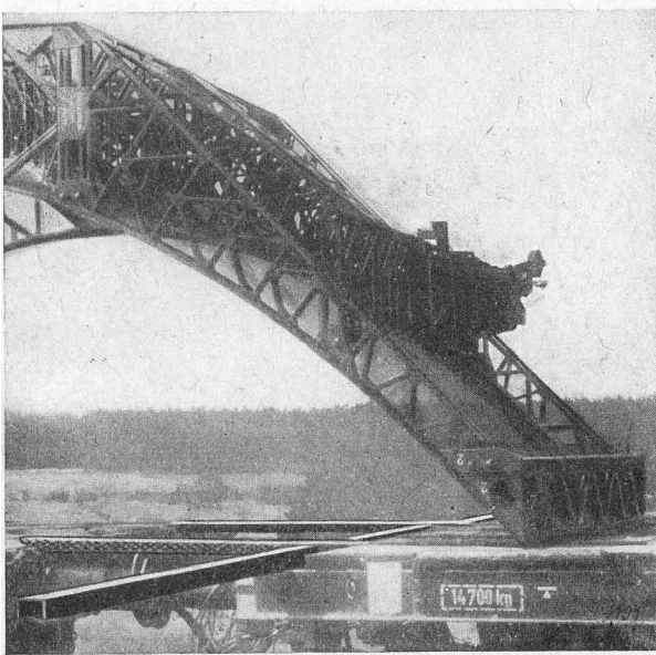
Bild 20. Zwischenschienen für Gleitschienenbrücke (II/15) zwischen Wagen II und Wagen III legen.
