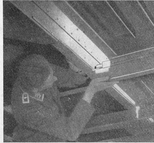
Bild 53 und 54. Plattform (IV/6) am Bedienungshaus einstecken und verriegeln.
